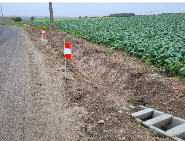
Création d'un exutoire par un fossé drainant en aval lointain du forage
