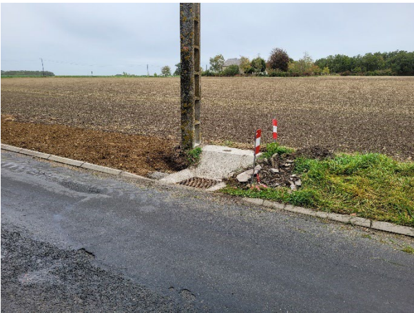
Pose de bordures pour canaliser les eaux de ruissellement vers un busage étanche via plusieurs avaloirs
