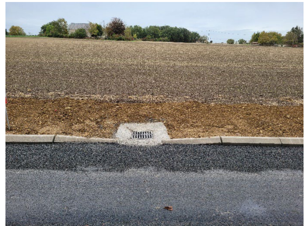
Pose de bordures pour canaliser les eaux de ruissellement vers un busage étanche via plusieurs avaloirs
